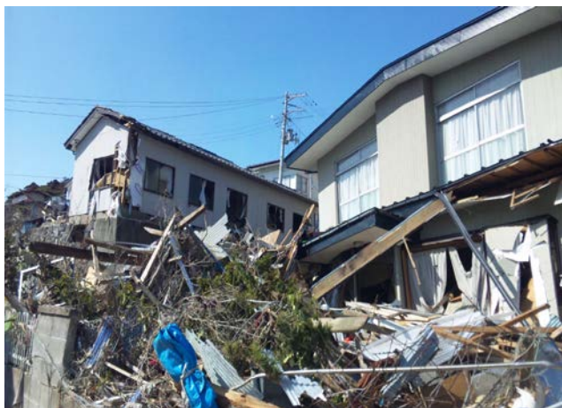
写真 被災した桂島の民家の様子
