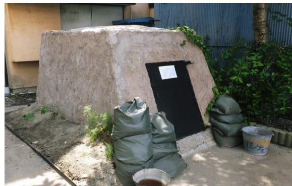
前橋市あたご歴史資料館に復元された防空壕 鉄は軍用のため土と木で作られ、防火性は弱かった
